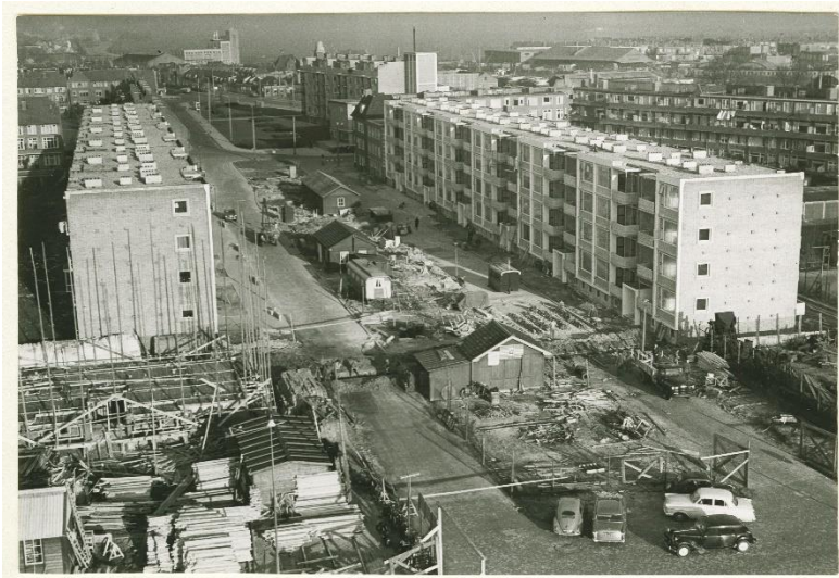
Bouw van galerijflats aan de Rembrandt van Rijnstraat, gezien naar het noorden. In het midden is ruimte vrijgehouden voor de geplande westelijke ringweg. Foto: Noord-Nederlands Persfotobureau Folkers. 1956. GA 2437-652.
