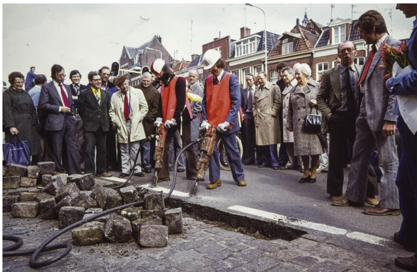
Wethouders Van den Berg en Wallage verwijderen asfalt van het Gedempte Zuiderdiep bij de symbolische start van het Verkeers-circulatieplan. Foto: Bureau Voorlichting gemeente Groningen, 13 mei 1977. GA 2485-4670.
