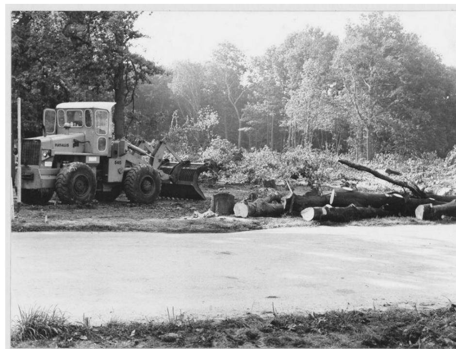
Kap van bomen bij de Middenlaan (later Laan 1940-1945) in het Stadspark en egalisatie van het terrein voor de aanleg van de westelijke ringweg,. Foto: Persbureau D. van der Veen, 21 augustus 1976. GA 1785-08871.
