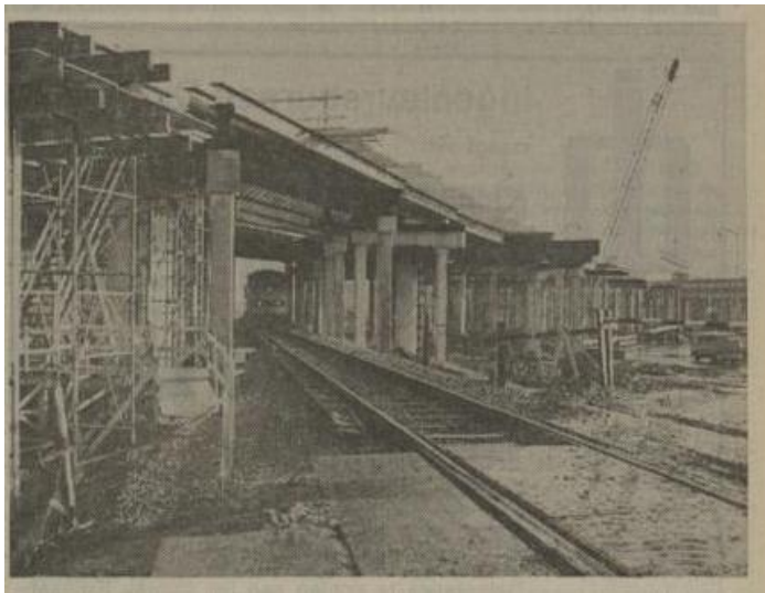
Aanbouw van het viaduct over de Peizerweg. NvhN 23 december 1976.
