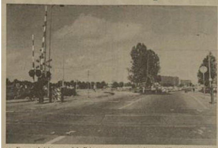
Spoorwegovergang Friesestraatweg en aansluiting op Westelijke ringweg, gezien naar het noorden. NvhN 17 augustus 1978.
