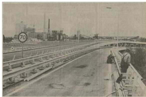
Het aanbrengen van vangrails bij de afrit ter hoogte van de Suiker Unie. Gezien naar het noorden.
