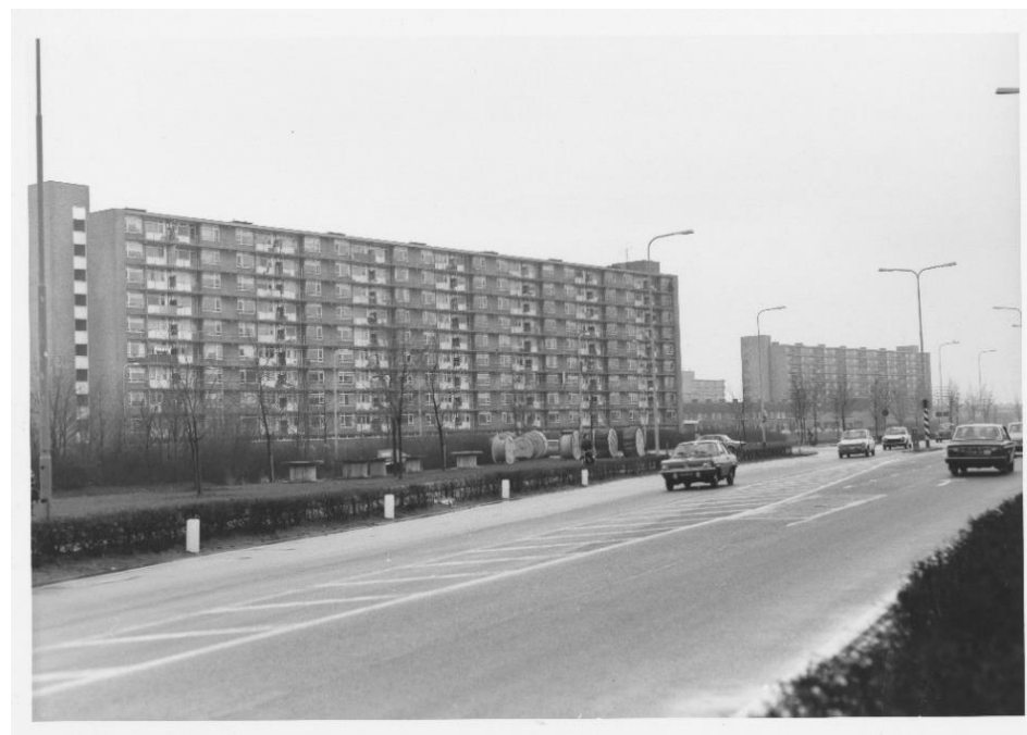
'Oude' Friesestraatweg met flats in Vinkhuizen, voor de aanleg van de westelijke ringweg, gezien naar het noordwesten. Foto: K.A. Gaasendam, 1977. GA 1785-9740.
