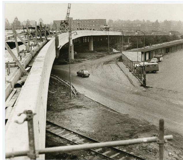
Aanleg van het viaduct Laan 1940-1945. Op de achtergrond de flats van Laanhuizen. Foto: Frank Staatemeier, oktober 1977. GA 2290-8604.
