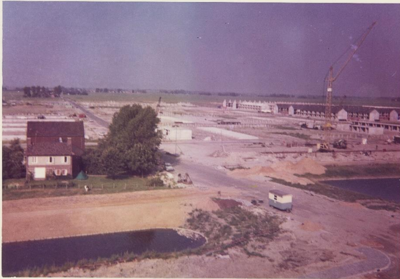
Begin van de bouw van het noordelijk deel van Vinkhuizen, gezien naar het westen vanaf het dak van melkfabriek De Ommelanden. Foto: J. Schotanus, dhr. Koers, 1968. GA 2138-3919.
