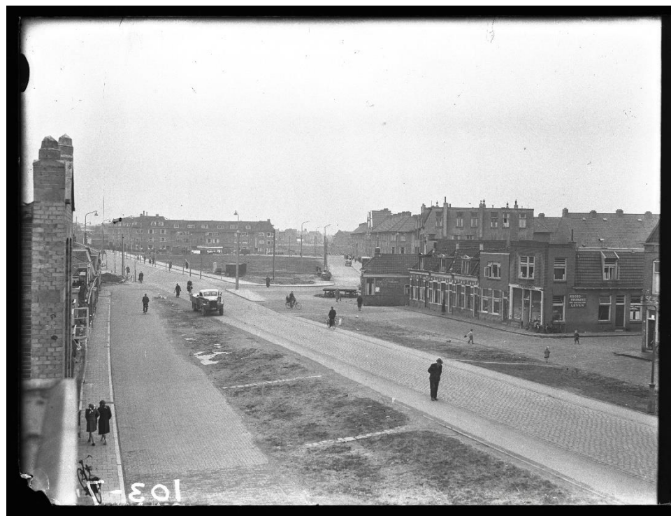
Friesestraatweg gezien naar het zuiden, ongeveer vanaf de huidige spoorwegovergang. Op de achtergrond naar rechts de afslag naar de Rembrandt van Rijnstraat. Duidelijk zichtbaar is het brede profiel van deze straat waar de ringweg is gepland. Foto: Fotobedrijf Piet Boonstra, 1950. GA 2248-727.
