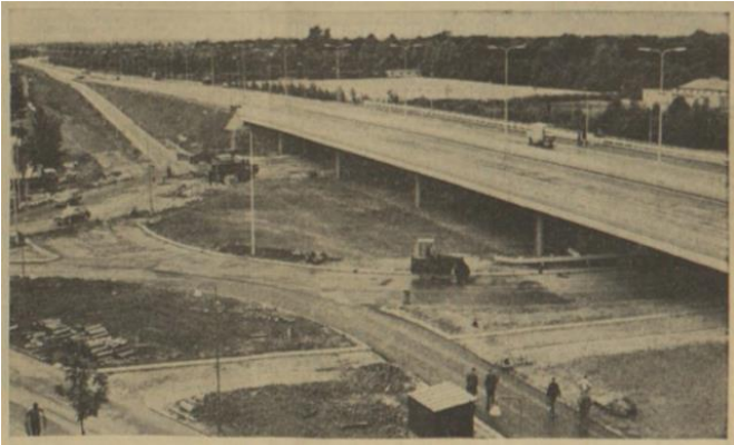
Viaduct van de Weg der Verenigde Naties, bij Laan Corpus den Hoorn, gezien naar het westen. NvHn 10 juli 1969.
