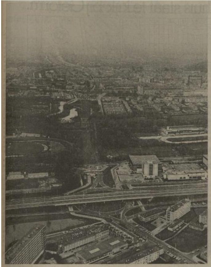
“De westelijke ringweg krijgt vorm” . Op de voorgrond de bebouwing van Corpus den Hoorn, daarachter de zuidelijke ringweg met rechts daarachter de Martinihal. Vanaf de rotonde onder de ringweg loopt het vrijgemaakte tracé van de geplande westelijke ringweg. NvhN 30 december 1976.
